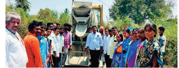
నీసి రోడ్డు నిర్మాణ పనులు ప్రారంభం
