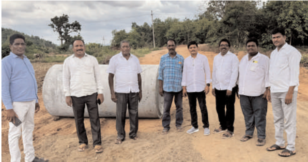
సాగుతున్నాయని బుగ్గారం మండల కాంగ్రెస్ పార్టీ అధ్యక్షులు వేముల సుభాష్ తెలిపారు. పనులు త్వరగా పూర్తి చేసి రోడ్డును వినియోగంలోకి తీసుకురావాలని మంత్రి అడ్డూరి లక్ష్మణ్ కుమార్ అధికారులను ఆదేశించిన మీదట సోమవారం రోడ్డు పనులను పరిశీలించామని సుభాష్ అన్నారు. ఈ సందర్భంగా సుభాష్ మాట్లాడుతూ ఇట్టి రోడ్డు పనికోసం గత బీ ఆర్ ఎస్ ప్రభుత్వంలో రెండు శిలాఫలకాలు పెట్టి పనులు చేయలేక వదిలేశారని
